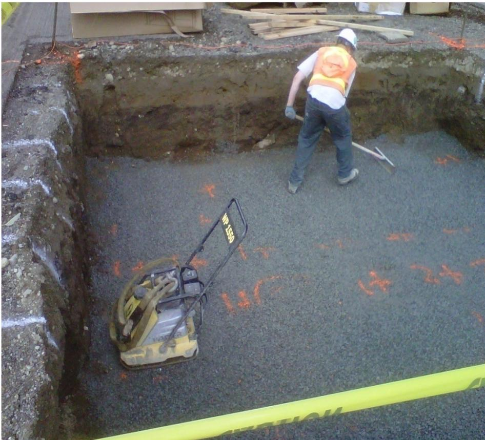
Effectuez un nivellement de finissage de l'agrégat de la sous-couche en une élévation ou une pente uniforme.
