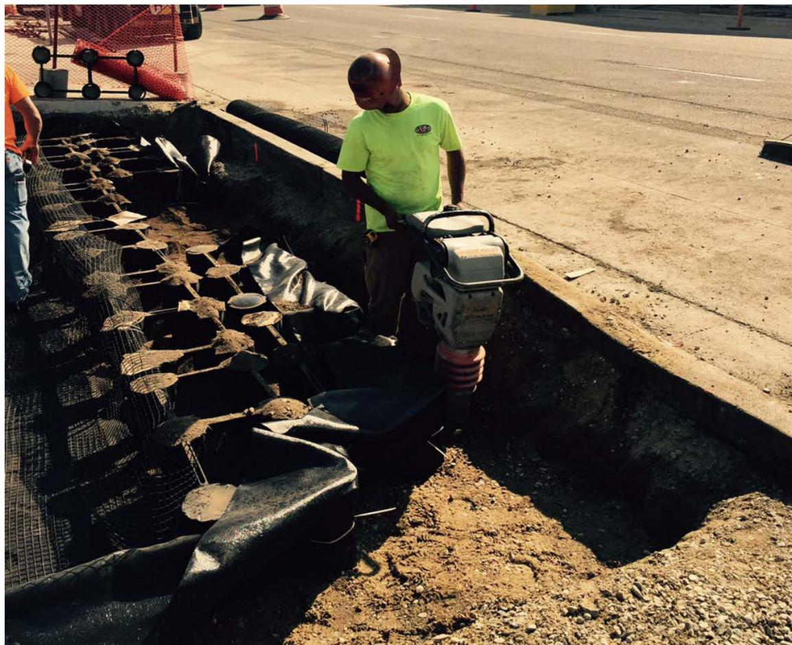
Faites en sorte que l'équipement de compactage n'entre pas en contact direct avec les piliers pour éviter de possibles dommages.
