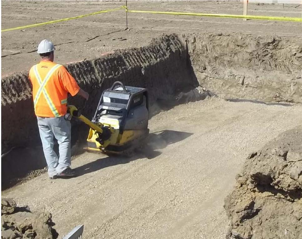
Placez l'épaisseur nécessaire d'agrégat de la sous-couche sur le tissu géotextile.
