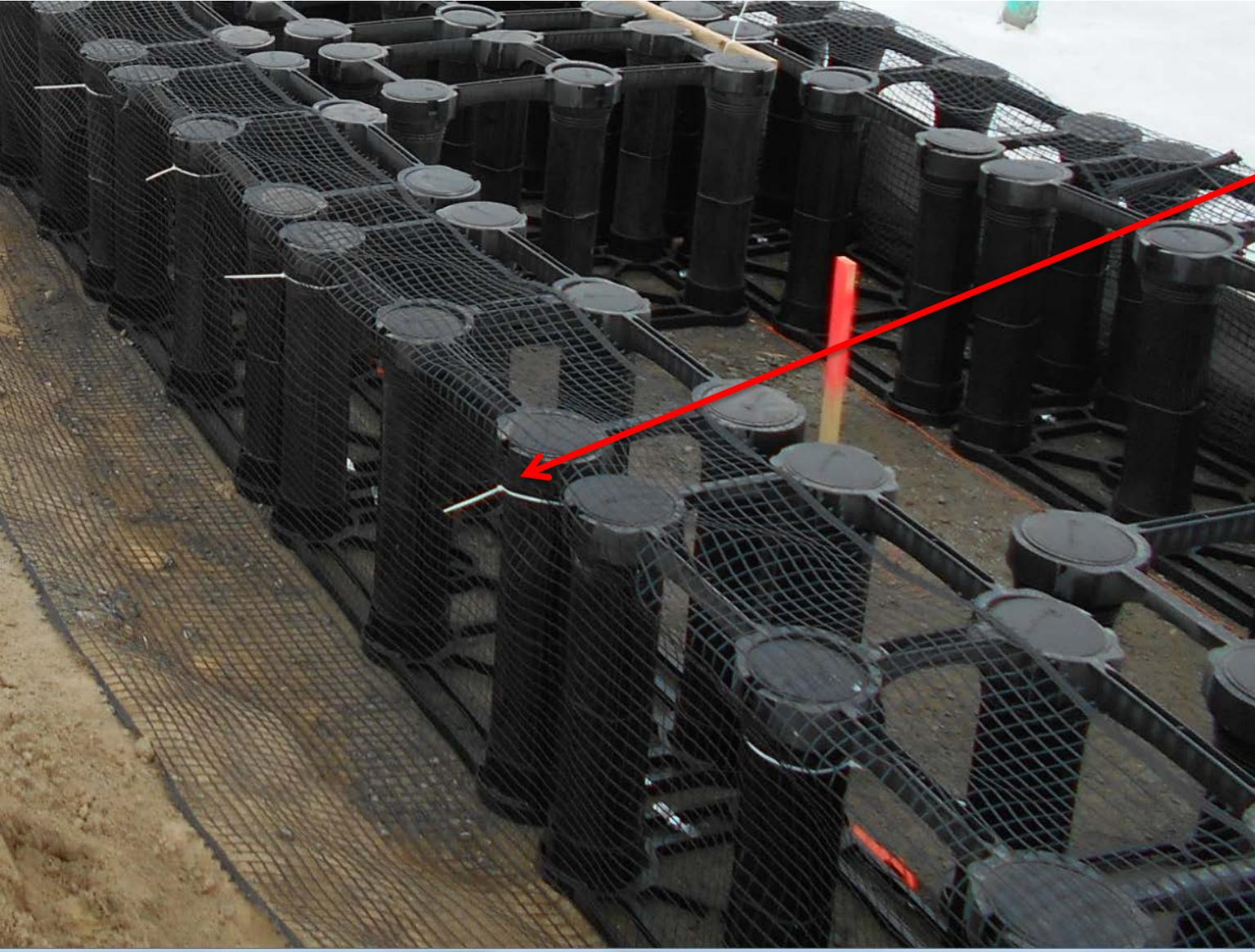
Fixez la géogrille aux piliers avec un collier de serrage pour maintenir la géogrille en place pendant le remblayage.
