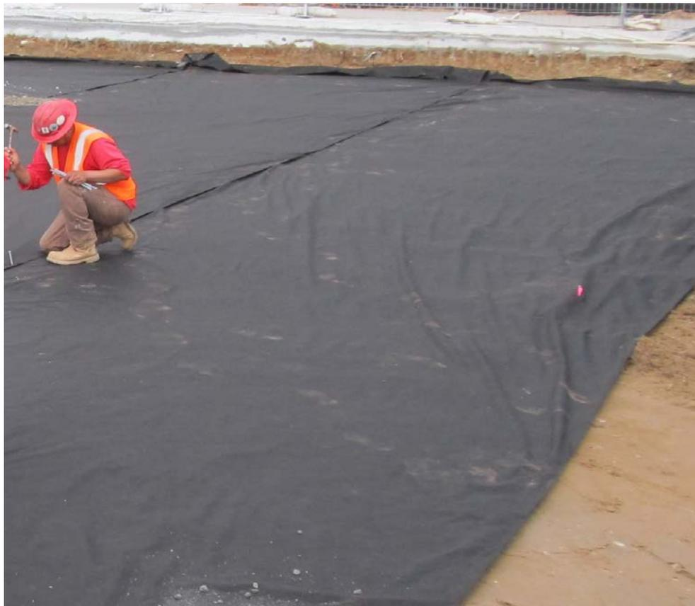
Placez une couche de tissu géotextile sur le sol de fondation compacté avant de placer l'agrégat de la sous-couche.
